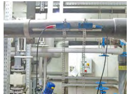
Wärmemengenmessung Stadtwerke München
