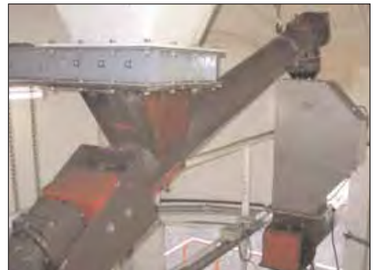
Regelung des Kalksteinmehl Austrages aus einem Silo
